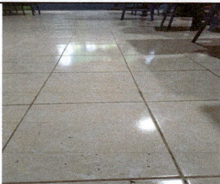
Foto 1: SUSTITUCION DE PISO DE CEMENTO POR PISO CERAMICO
