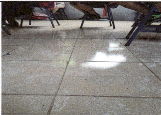
Foto 3: SUSTITUCION DE PISO DE CEMENTO POR PISO CERAMICO
