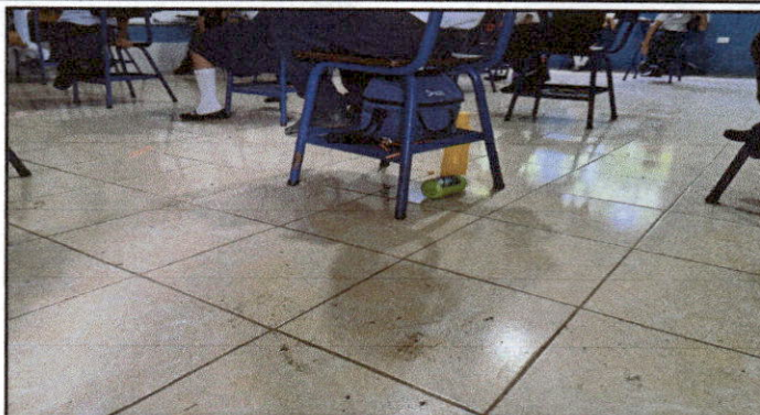
Foto 2: SUSTITUCION DE PISO DE CEMENTO POR PISO CERAMICO
