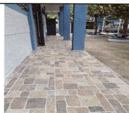
Foto 6: SUSTITUCION DE PISO DE CEMENTO POR PISO CERAMICO
